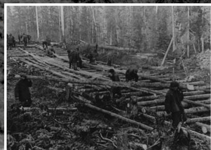
Na zdjęciu: wycinka drzew na potrzeby budowy Kanału Białomorskiego, 1931–1933. Fot. Ośrodek Karta
