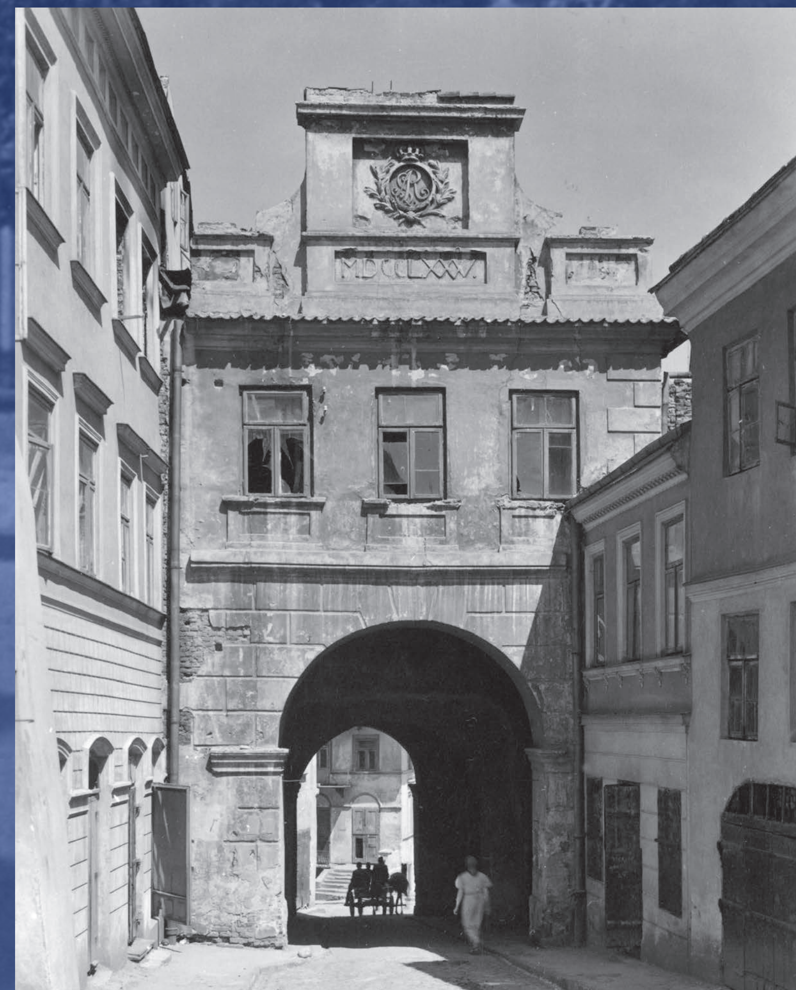
Brama Grodzka (Brama Żydowska) w Lublinie – przejście do getta Fot. NAC
