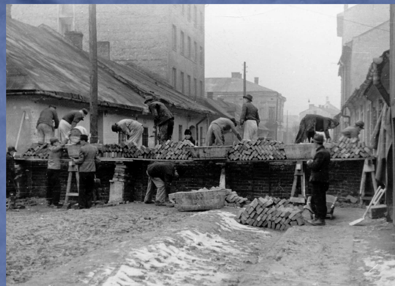
Budowa muru na granicy getta krakowskiego Fot. AIPN
