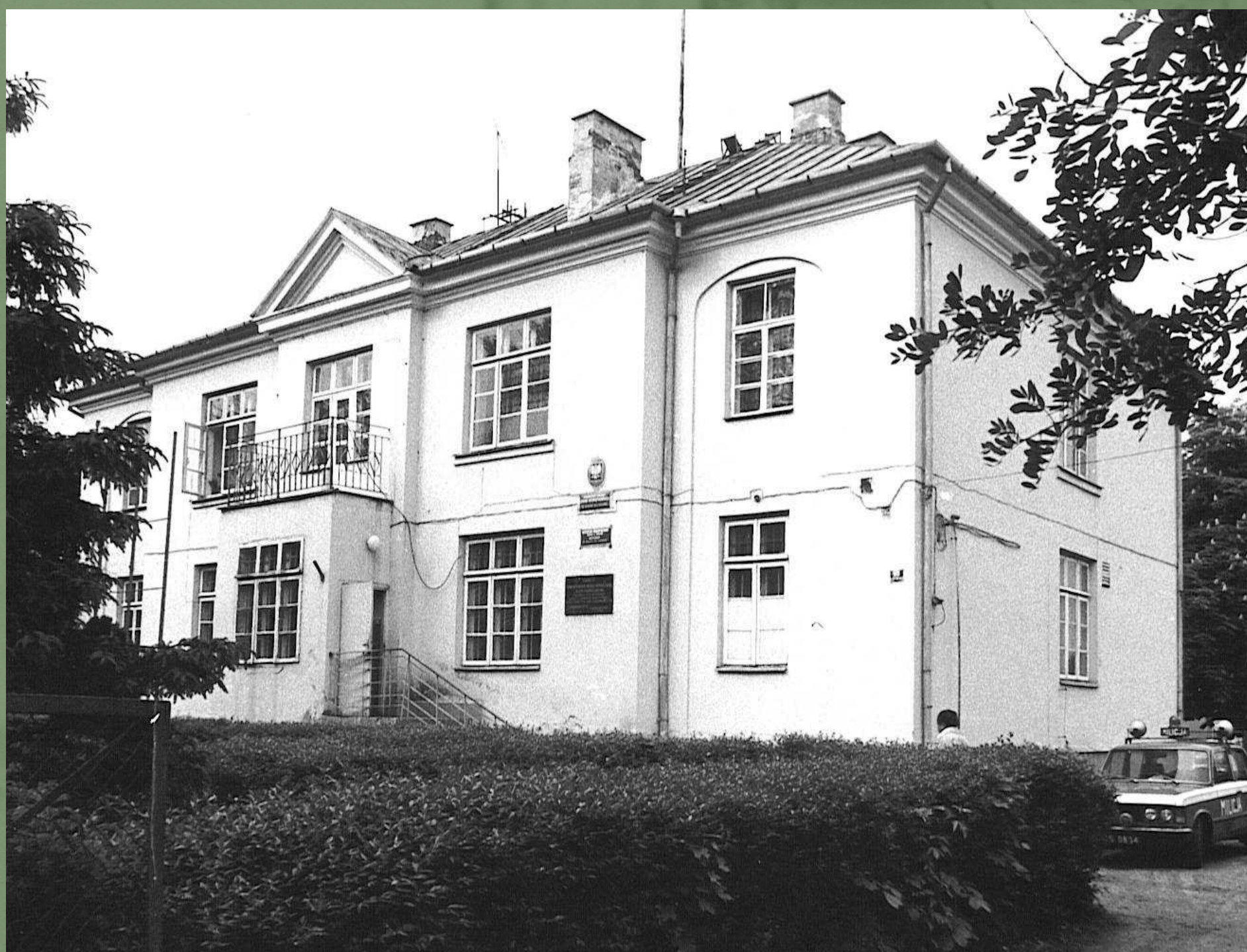
Budynek, w którym w latach 1944–1956 miał swoją siedzibę Powiatowy Urząd Bezpieczeństwa Publicznego we Włodawie. Zdjęcie z lat 80. XX w., kiedy mieściła się w nim Komenda Powiatowa Milicji Obywatelskiej. Fot. zbiory autora.
