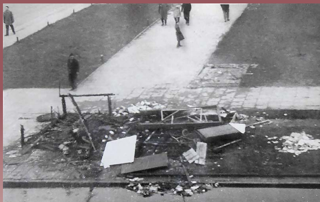
Spalony kiosk „Ruchu”, znajdujący się naprzeciwko budynku Dzielnicowej Rady Narodowej. Fot. AIPN.
