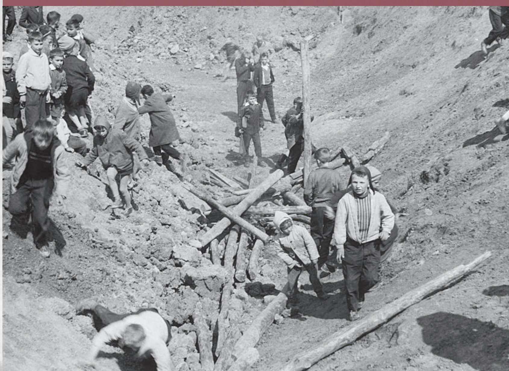
Bawiące się dzieci wrzucały drewniane elementy budowlane do wykopu. Fot. AIPN.
