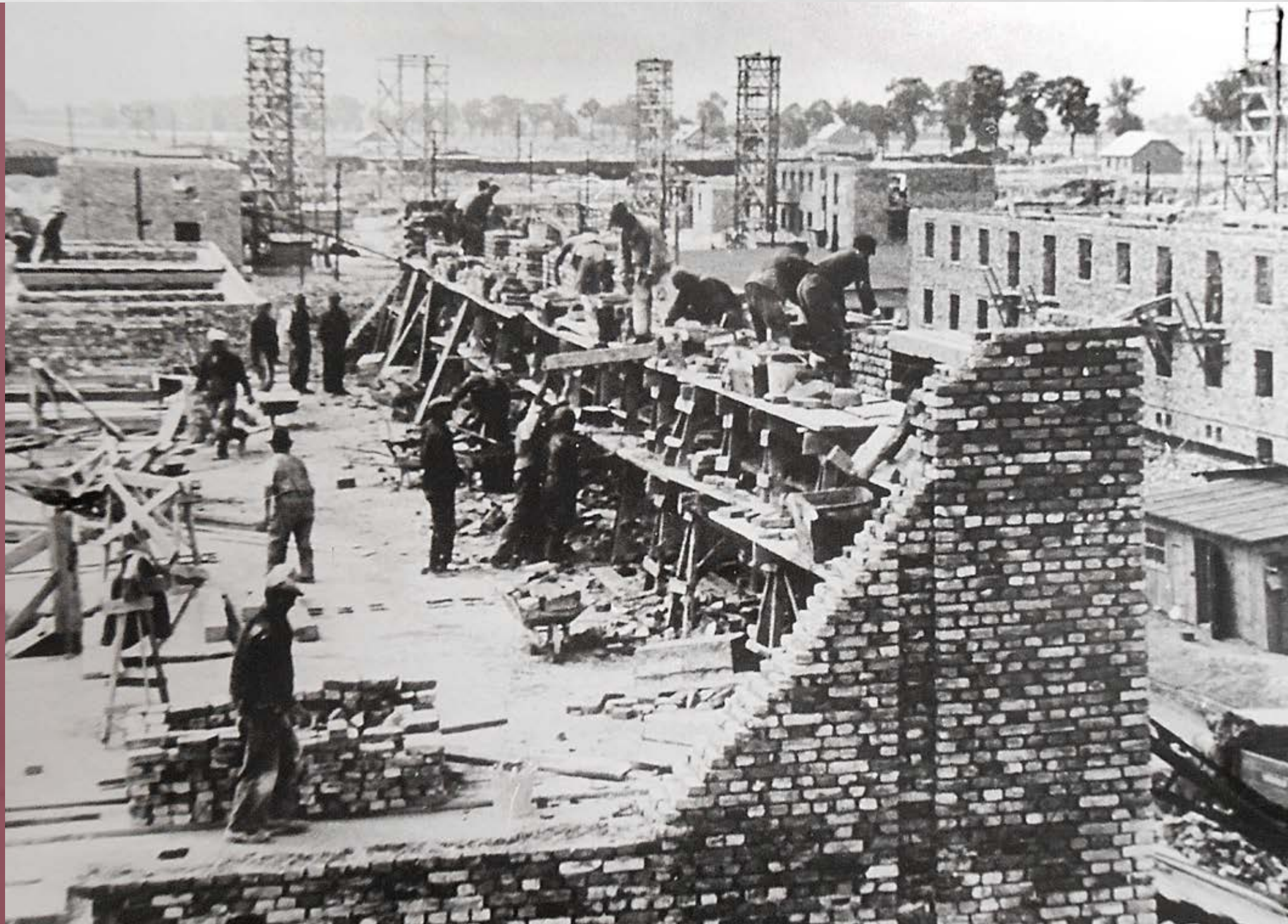
Brygada murarska przy pracy. Fot. Archiwum Jerzego Ridana.
