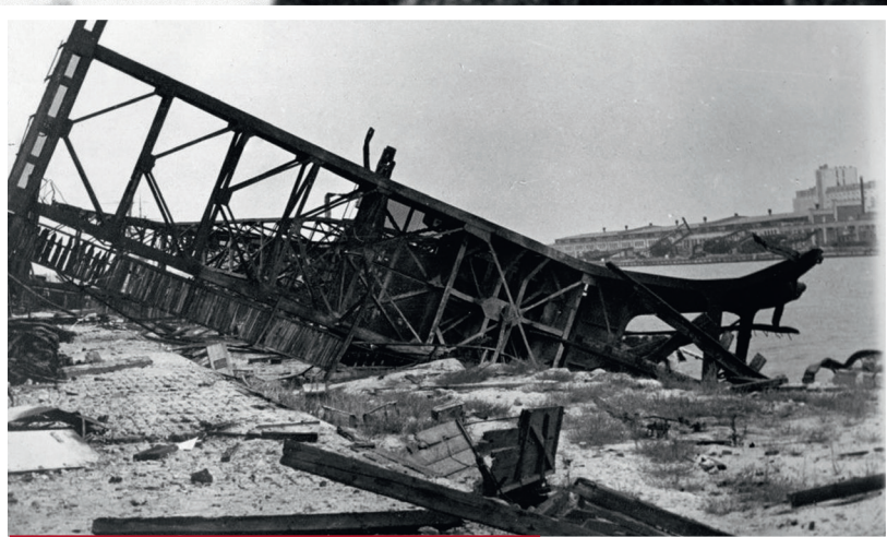
Zniszczone urządzenia przeładunkowe Nabrzeża Rumuńskiego w gdyńskim porcie (APG).
